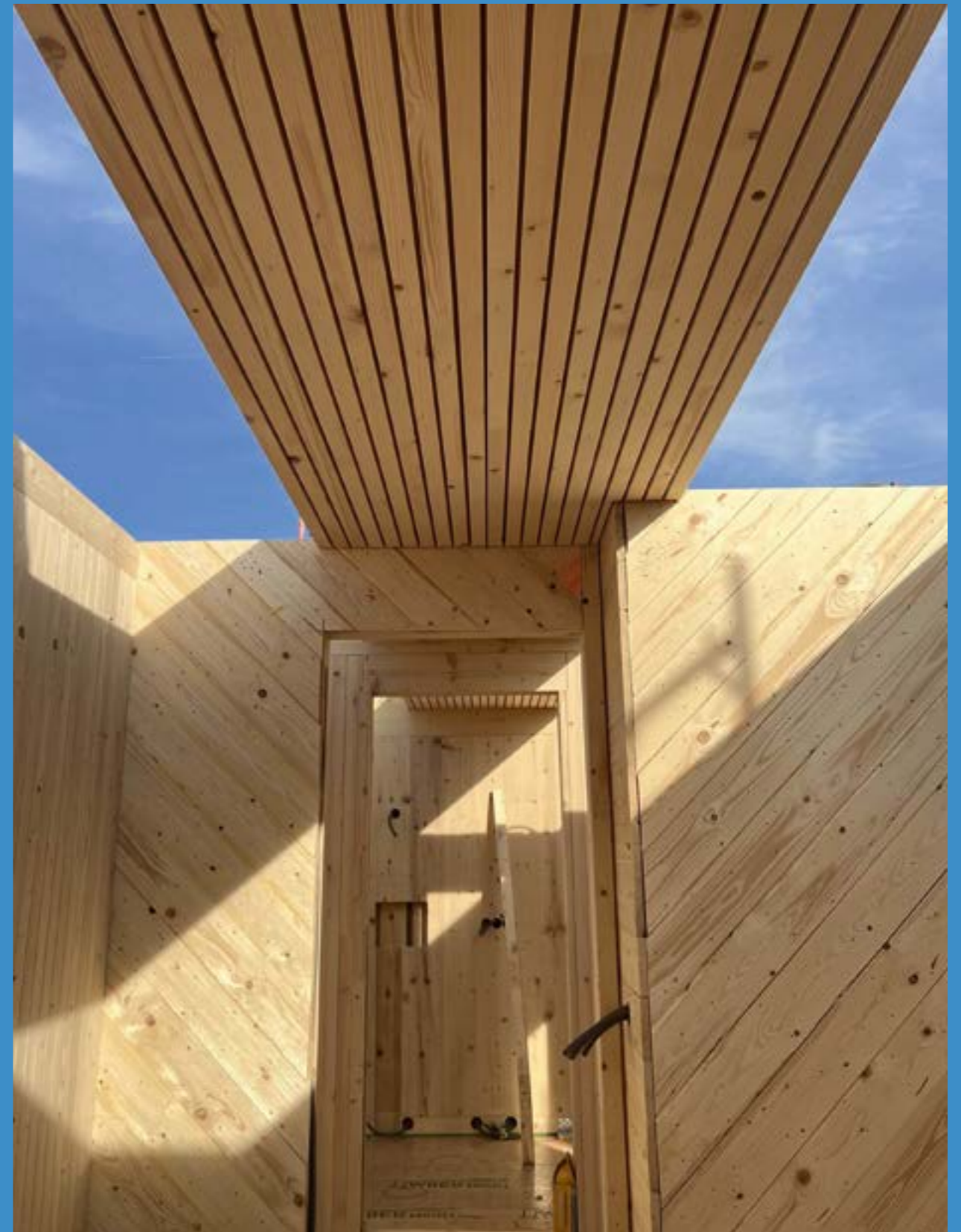
Konstruktion des neuen Mitarbeitergebäudes
