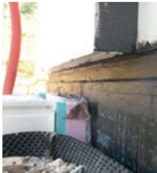
Grâce aux produits, comme la pâte d'étanchéité applicable au pinceau, même des constructions de soubassements complexes peuvent être étanchéifiées.
