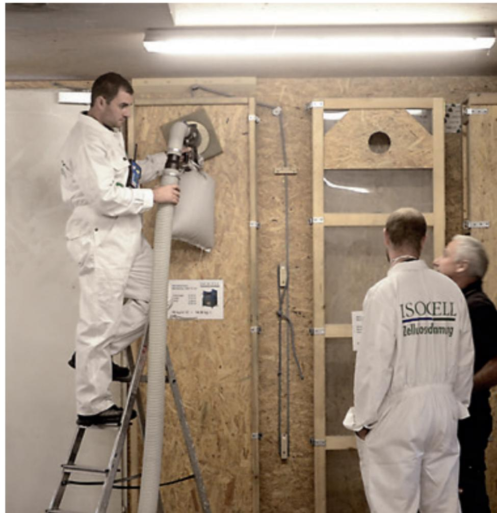
Le formateur montre en direct l'insufflation de la ouate de cellulose dans des caissons, les techniques à employer et la diversité des produits proposés par l'entreprise.
