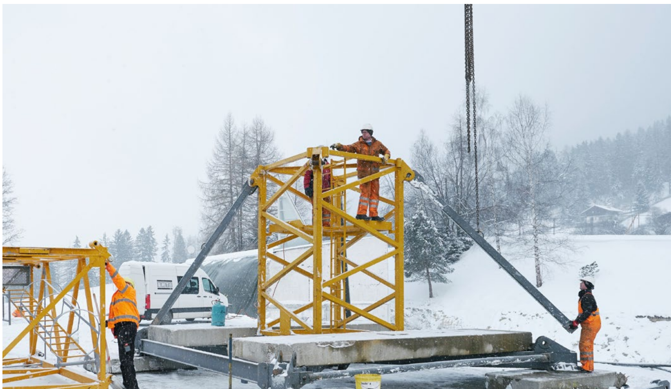
Der renommierte Architekturfotograf David Schreyer begleitet den Baufortschritt des Bildungshauses.
