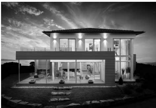
L'architecture Griffner est moderne, tout comme l'intérieur des maisons.
