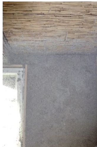
EINGEBLASENE ZELLULOSE: Kay Künzel verwendet fast ausschließlich ISOCELL-Dämmstoffe
