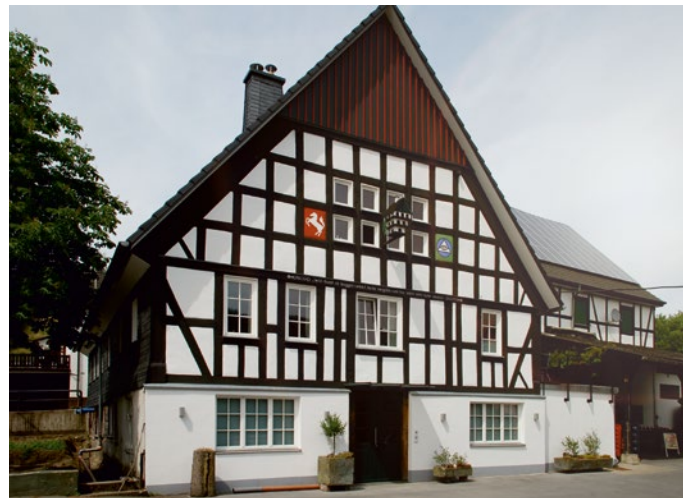
ES MUSS NICHT IMMER EIN NEUBAU SEIN: Auch alte Gebäude mit Charakter können auf Passivhausstandard gebracht werden
