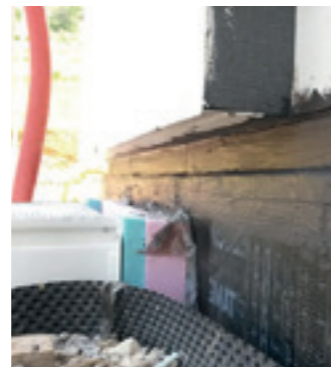
Mit streichbaren Sockelabdichtungen werden auch komplexe Übergänge dicht
