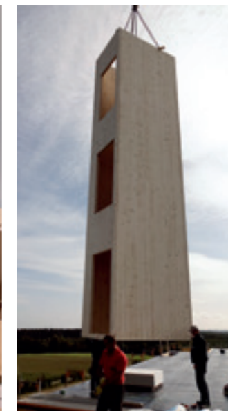
30 Meter hoch ragt das Bauwerk am Standort Aalen-Waldhausen in den Himmel.
