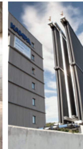
Nach nur wenigen Monaten Bauzeit wurde das K8 im Frühjahr 2015 offiziell eröffnet.
