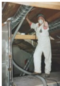
Archivbilder unter dem Motto „Damals schon gut, heute noch innovativer“: Die ISOCELLER beim Zellulose-Einblasen
