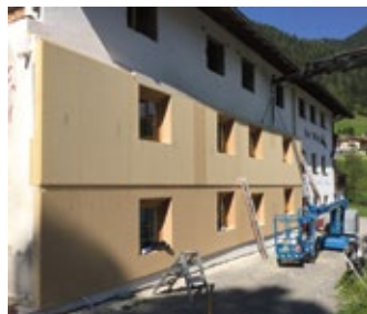
Die Montage der Fassade
