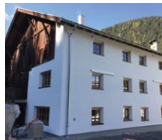
Die fertige Fassade
