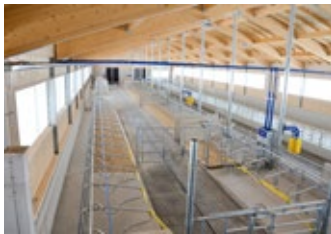
Gebäude für die Landwirtschaft waren stets wichtiger Teil des Firmenportfolios.
