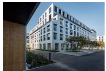
Nur eines der 20 Gebäude, die in Holzbauweise entstanden.
