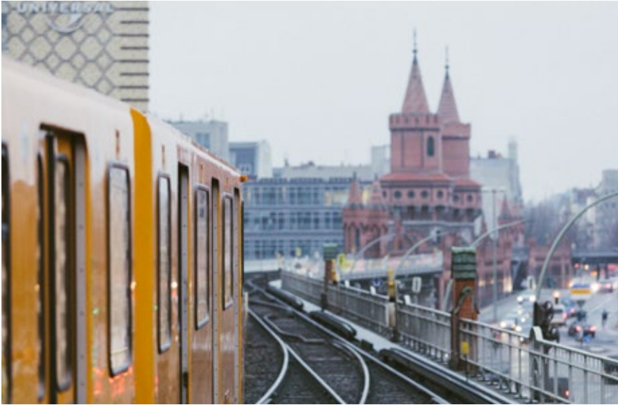
Die Warschauer Brücke und die Oberbaumbrücke – eines der berühmtesten Wahrzeichen Berlins
