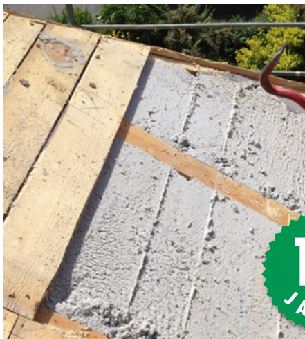
Nach 17 Jahre geöffneter Dachstuhl: ISOCELL Zellulose wirkt wie frisch eingblasen...
