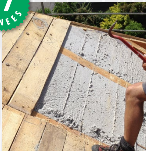
Ouverture d'un toit après 17 ans (Maison au Tyrol); on dirait que la ouate vient d'être insufflée.
