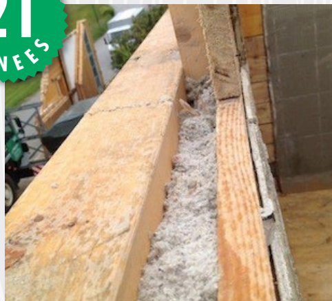
Démontage d'une maison préfabriquée après 21 ans on constate clairement (Basse Autriche / Wr. Neustadt).
