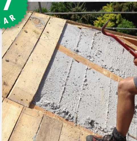
Na 17 jaar werd het dak geopend (huis in tirol) De ISOCELL cellulose werkt zoals net ingeblazen.
