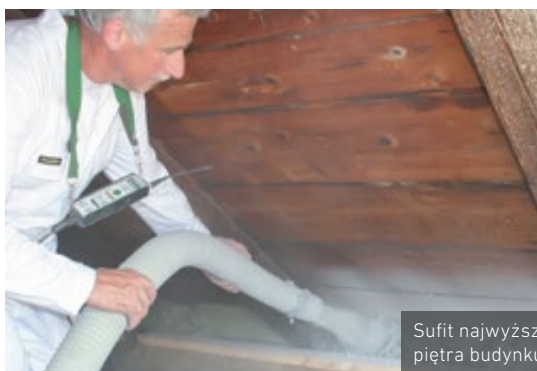
Wdmuchiwanie do przestrzeni sufitowej
