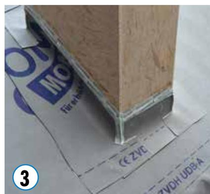
L'étanchéité de l'extrémité supérieure autour de la cheminée peut également être renforcée avec le ruban adhésif AIRSTOP ULTRA.
