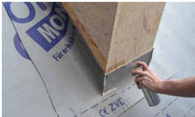
L'application d'un primaire (par ex. l'aérosol primaire UNI) est recommandée si l'extrémité supérieure est rendue étanche avec de la bande adhésive AIRSTOP.
