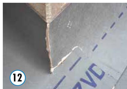
10 11 12 Rendre étanches tous les raccords et recouvrements en partie inférieure avec le colle de raccord OMEGA QUILLI.
