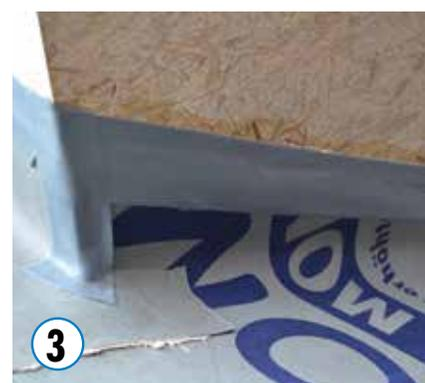
Les bandes latérales de raccord au niveau de la cheminée peuvent également être réalisées avec ruban élastique Butyl. Appliquer si nécessaire au préalable un Primer.
