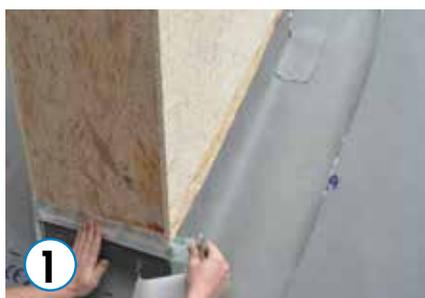
1 En outre, l'extrémité supérieure peut être rendue étanche avec le ruban adhésif AIRSTOP FLEX. Appliquer au préalable si nécessaire un primaire.
