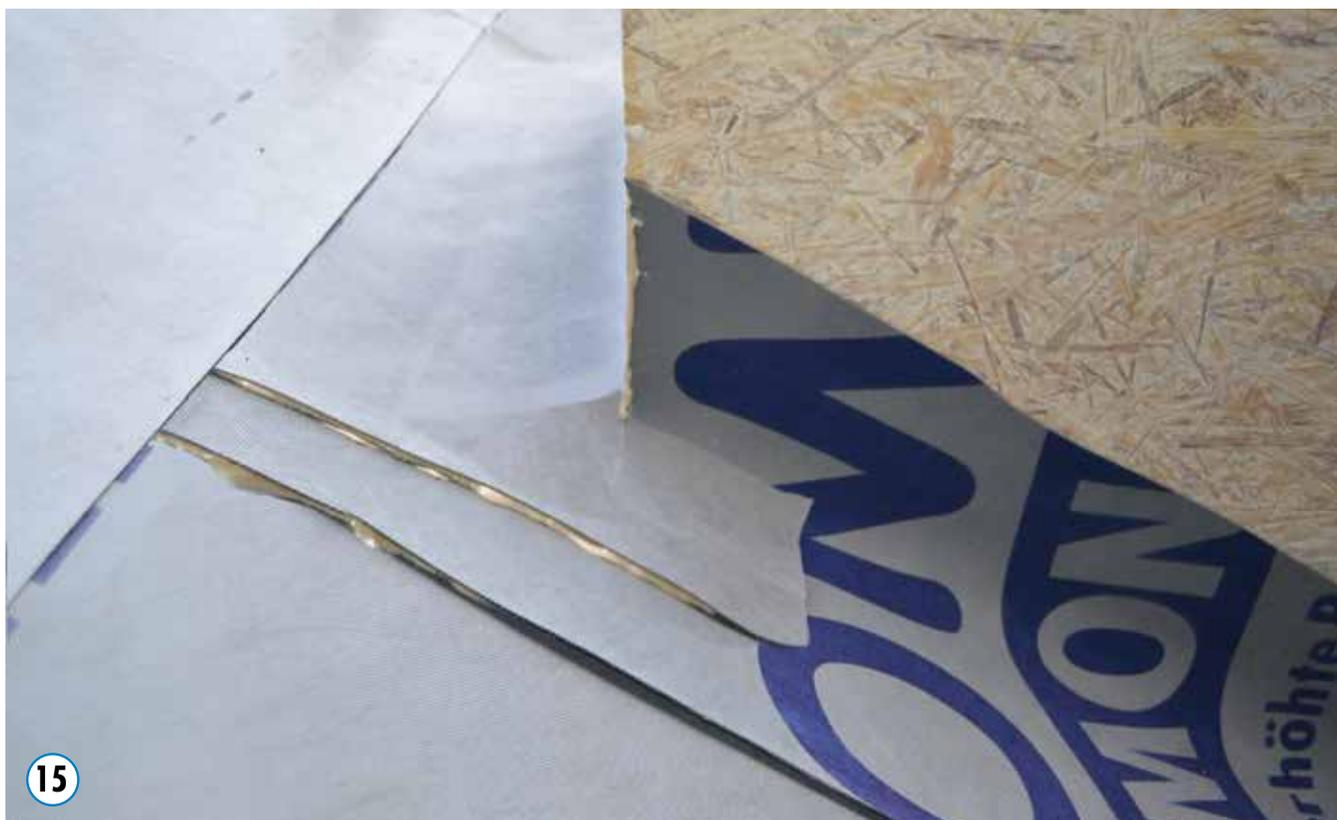
Poser la tôle de rejet d'eau, ou bien réaliser l'extrémité supérieure avec une façon de pente à partir d'une largeur de construction de plus de 1000 mm parallèlement au chéneau.
