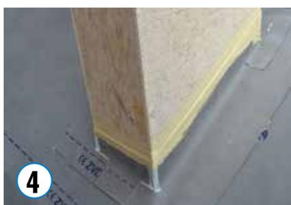
4 Les zones collées avec le ruban adhésif AIRSTOP FLEX peuvent en plus être recouvertes de pâte d'étanchéité OMEGA LIQUID.
