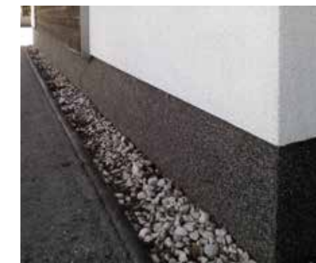
Réalisation conforme à la norme
