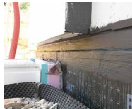
Même des jonctions complexes deviennent étanches grâce aux étanchéités recouvrables pour soubassements
