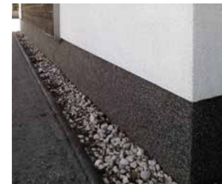
Réalisation conforme à la norme
