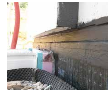
Même des jonctions complexes deviennent étanches grâce aux étanchéités recouvrables pour soubassements
