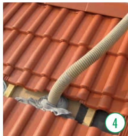
Dans le cas de toitures déjà couvertes, il suffit de retirer quelques tuiles pour effectuer les travaux d'isolation.
