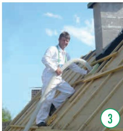
De l'isolation en cellulose est insufflée après la réalisation de la sous-toiture. Dans la cavité de remplissage, les fibres s'enchevêtrent pour former une natte isolante compacte et continue.
