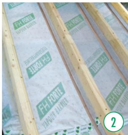
I vecchi falsi puntoni offrono raramente uno spazio sufficiente per gli odierni standard di isolamento. Per ottenere il necessario spessore isolante, il falso puntone viene raddoppiato.
