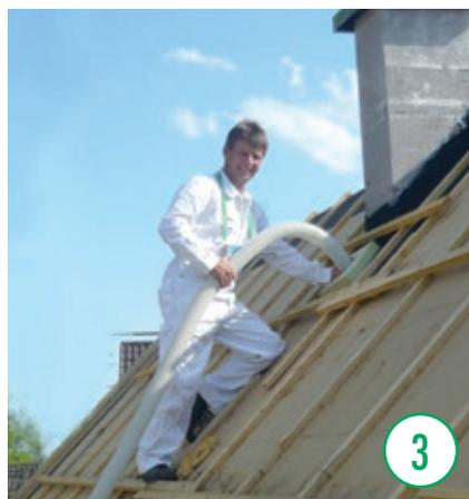
Dopo il completamento del sottotetto, l'isolamento celluloso viene introdotto mediante tecnica di insufflaggio. Nello scomparto le fibre si infeltriscono formando un tappetino isolante senza giunti.
