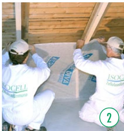
Il freno al vapore viene posato in modo sovrapposto e fissato meccanicamente tramite punti metallici.
