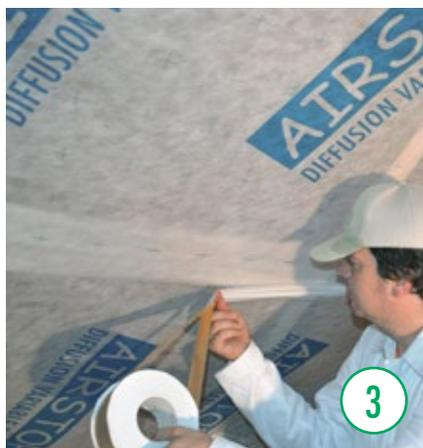
È molto importante l'incollaggio a tenuta d'aria e l'impermeabilizzazione di sovrapposizioni, raccordi ed elementi passanti. Vedi a tale scopo l'opuscolo "Tenuta all'aria in dettaglio".
