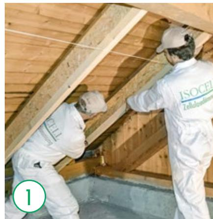
In base allo spessore coibente, i falsi puntoni vengono rinforzati (raddoppiati) sul lato interno dello spazio sottotetto. Per la costruzione qui sono raffigurate due varianti (vedi disegni dettagliati).
