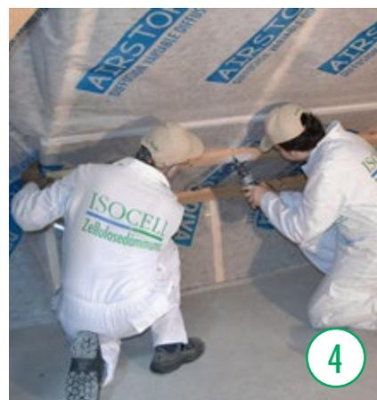
Ora le assicelle vengono montate nella distanza assiale di circa 30 cm. La listellatura viene posizionata direttamente sul rivestimento del giunto al fine di scaricare ulteriormente i punti adesivi.
