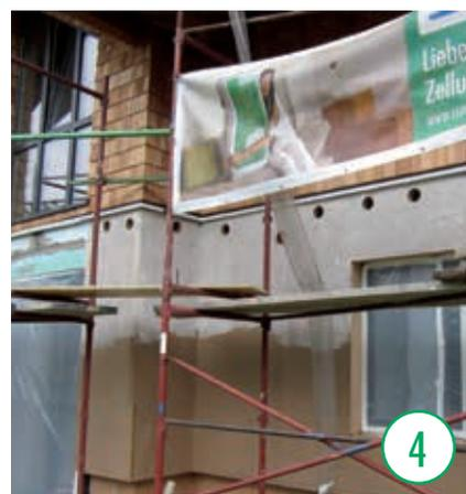
Juste avant de réaliser l'isolation cellulosique ISOCELL, on perce des trous dans les plaques pour pouvoir amener le tuyau d'insufflation jusque dans le vide.
