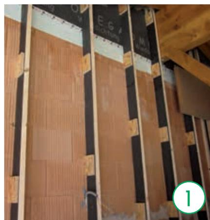
En fonction de l'épaisseur de l'isolant, pour réaliser les vides, on cheville des lattes en bois, des poutrelles TJI ou des constructions en bois sur le mur. L'entraxe dépend des exigences du matériau utilisé comme support d'enduit.
