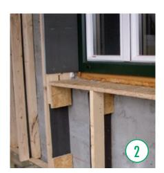
Gli intradossi delle finestre e delle porte devono essere chiusi tutt'intorno. Cavità inferiori ai 10 cm vengono riempiti manualmente con cellulosa.
