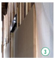
Il materiale di supporto portaintonaco viene montato sui distanziatori allineati a piombo. Nel caso di facciate ventilate viene applicato un pannello a base di legno aperto alla diffusione.
