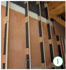
A seconda dello spessore coibente, per la creazione delle cavità vengono tassellati al muro assicelle di legno, travi a doppio T o costruzioni in legno. L'interasse si orienta alle esigenze del materiale di supporto portaintonaco di volta in volta utilizzato.
