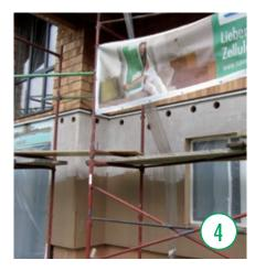
Poco prima di introdurre l'isolamento cellulosico ISOCELL, vengono forate le cavità per il tubo d'insufflaggio.
