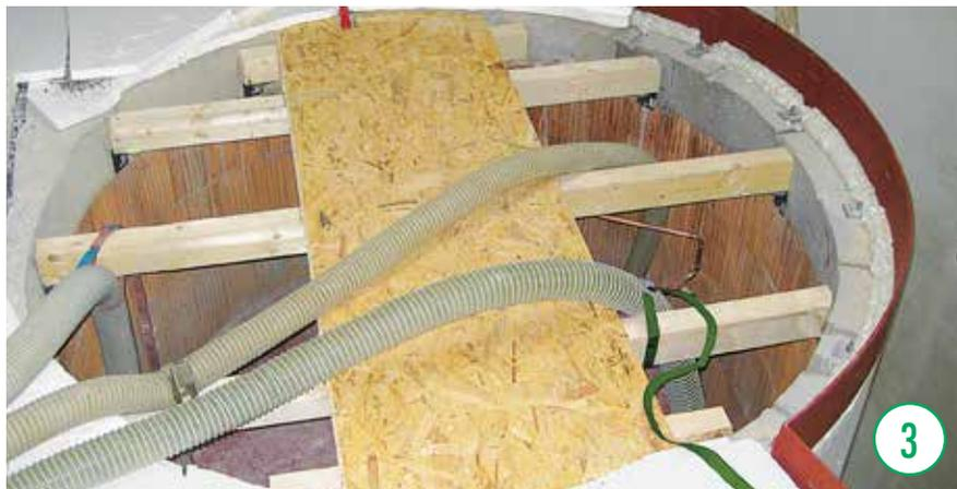
Avant l'insufflation, la chaudière doit être contrôlée à chaud. L'insufflation s'effectue à froid afin d'éviter la formation de cavités en cas de variations dimensionnelles.
