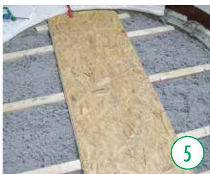
Sur 25 ans, l'isolation cellulose insufflée autour du ballon tampon a permis de minimiser les déperditions thermiques.
