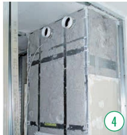
Une lance peut également servir à l'isolation de gaines. On distingue sur l'illustration une gaine insufflée avec son habillage retiré. La cellulose s'introduit dans les plus petits interstices. Un résultat optimal.
