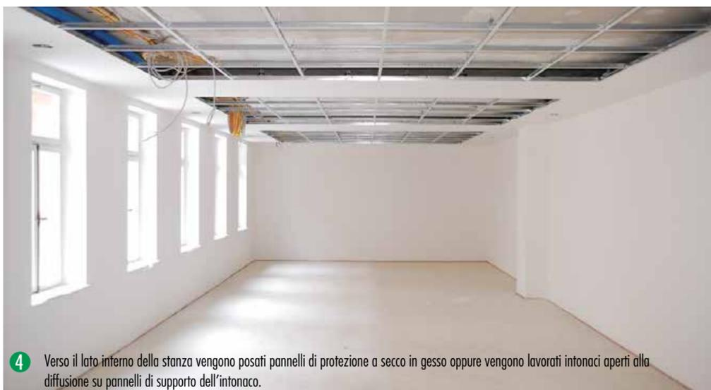
Verso il lato interno della stanza vengono posati pannelli di protezione a secco in gesso oppure vengono lavorati intonaci aperti alla diffusione su pannelli di supporto dell'intonaco.
