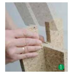
Les élément WoodyFix sont livrés sur des palettes, emballés par paquets. On peut donc les monter sans difficultés jusqu'aux combles en fonction des besoins. Le module s'obtient simplement par assemblage sur place.
