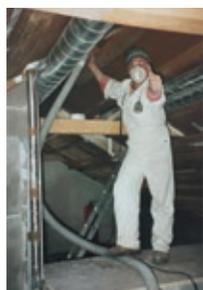
Photos d'archives sous la devise "Déjà performant à l'époque, encore plus innovateur de nos jours": Les ISOCELLER lors de l'insufflation de cellulose
