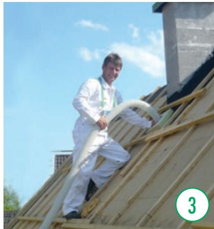
Nach Fertigstellung des Unterdaches wird mittels Einblastechnik die Zellulosedämmung eingebracht. Im Gefach verfilzen sich die Fasern zu einer kompakten, fugenlosen Dämm-Matte.
