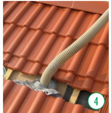
Bei bereits gedeckten Dächern müssen nur wenige Ziegel ausgehängt werden, um Platz für die Dämmarbeiten zu schaffen.
