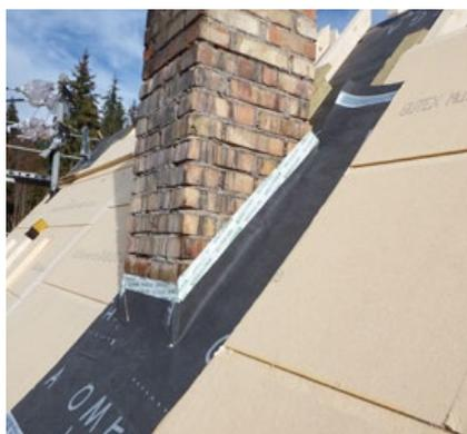
Die Oberfläche ist gegebenenfalls vorzuprimern. Bei entsprechend geringem Fugenmaß kann der Kaminanschluss auch mit einem Klebeband (OMEGA PLASTO Band, BUTYL Dehnflex, AIRSTOP ULTRA) hergestellt werden.
