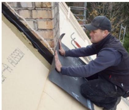
Die OMEGA Dachbahn kann mit der OMEGA QUILLI Dichtmasse oder dem AIRSTOP ULTRA Klebeband verklebt werden und sollte 15 cm hochgezogen werden.
