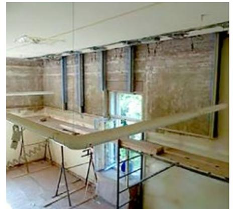
Installierte Messfelder vor Anbringung der Dämmsysteme.
