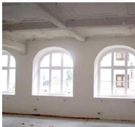
Beim Landesamt für Finanzen in Augsburg wurde ebenfalls ISOCELL Zellulose für die Innendämmung verwendet. ISOCELL Zellulosedämmstoff mit 8 cm Stärke verbessert hier den Wärmedurchlasswiderstand der Wand und hilft den Heizkostenaufwand zu reduzieren.
