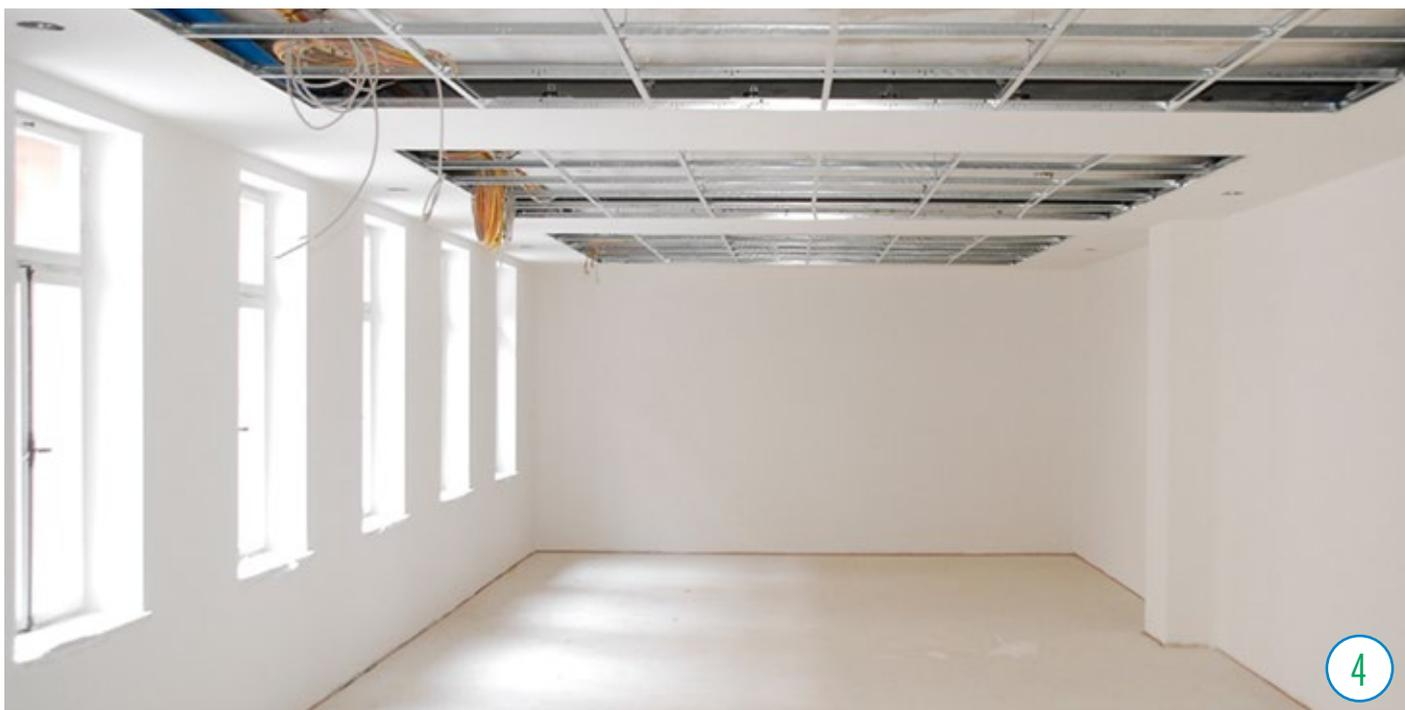
Zur Rauminnenseite werden entweder Trockenbauplatten aus Gips verlegt oder auf Putzträgerplatten diffusionsoffene Putze verarbeitet.
