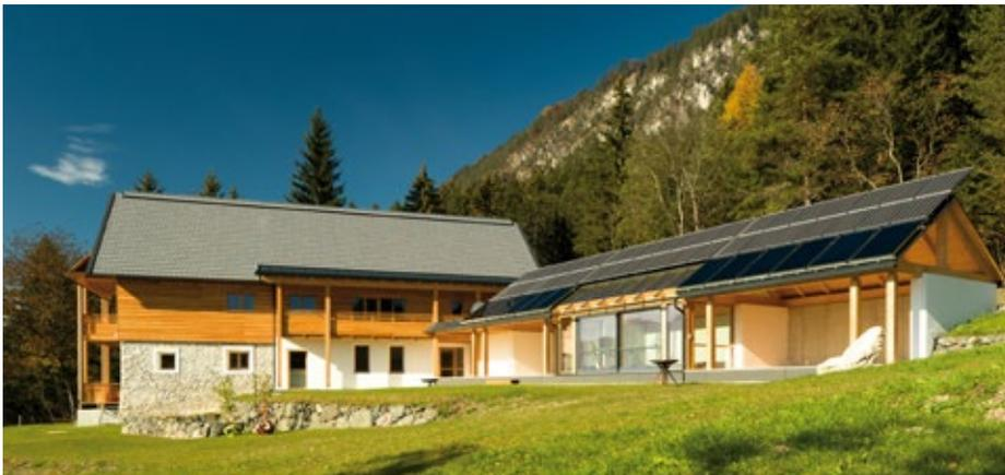
Da die bestehende Natursteinfassade im Erdgeschoss aus architektonischer Sicht erhalten werden sollte, wurde auf eine konventionelle Außendämmung in diesem Bereich verzichtet.
