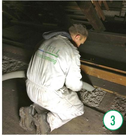
Mittels Funk steuert der Einblas-Fachmann die Einblasmaschine im LKW, die ein Helfer mit ISOCELL Zellulose befüllt.
