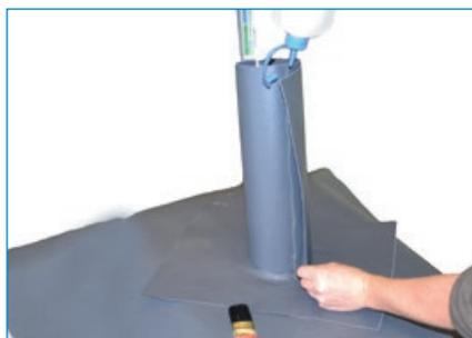
Rohrummantelung mittel OMEGA N55 Klebstoff oder Heissluftpistole untereinander verbinden.
