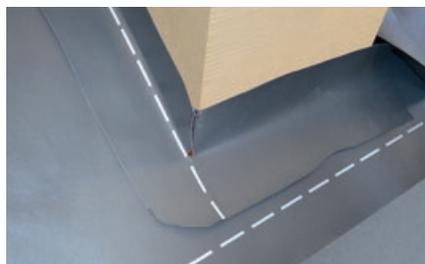
Manschettenecke abrunden und alle Formteile am Kamin und an der Dachauflegebahn wasserdicht anschließen. Ausführung der oberen Anschlussbahn mit den empfohlenen 10 cm Überständen ausführen.
