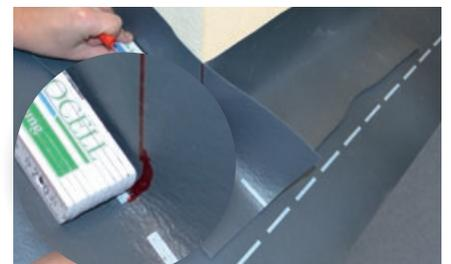
Im unteren Eckbereich mittels Hilfsmittel eine „Wassermasse“ einplanen.
