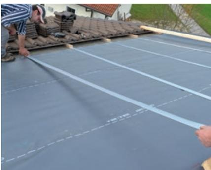
Unter den Konterlatten sind die ISOCELL Nagel-dichtbänder einzusetzen.
