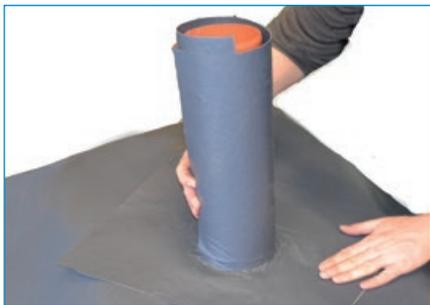
Bei Verklebung mit OMEGA N55 Klebestelle fest andrücken und ggf. die Klebeverbindung mittels Klebeband bis zur Trocknung des Klebers sichern.
