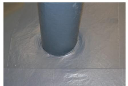
Überlappungsverklebung am hochgestellten Hochzug fest andrücken. Übriges auch mittels Heissluftpistole möglich.
