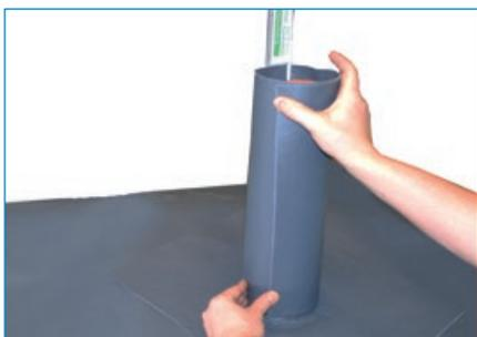
Bei der Ermittlung des Rohrumfanges Hilfsmittel (z.B. Zollstock) als Abstandhalter verwenden.
