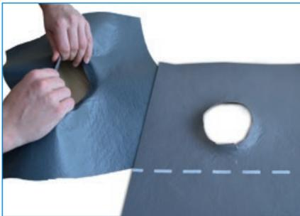
Dachbahn ca. 1 cm einfallen und gesamten Rohrdurchmesser vordehnen.
