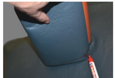
Neigung des Daches auf die vorgefertigte Manschette projizieren und zuschneiden.
