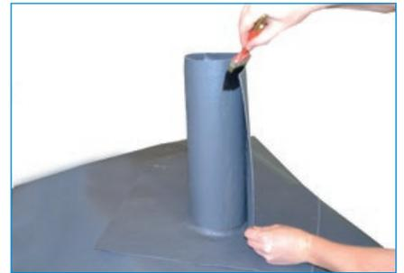
Abschließend Rohrummantelung mittels OMEGA N55 Klebstoff oder Heissluftpistole untereinander verbinden.
