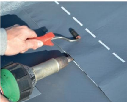
Überlappungsverklebung mittels Heissluftpistole.
