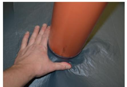
Formteil vollflächig bis zur Dachfläche führen und ankleben.
