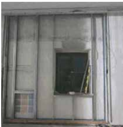
Rahmensystem für die vorgeständerte Innendämmkonstruktion durch Zellulose-Einblasdämmung. © Fraunhofer Institut für Bauphysik IBP
