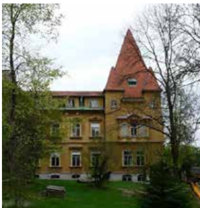
Ansicht der nach Südwestsüd ausgerichteten Fassade des Testhauses
