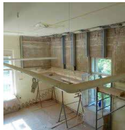
Installierte Messfelder vor Anbringung der Dämmsysteme.
