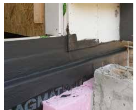
OMEGA PoBit für die Sockelabdichtung
