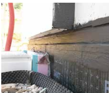
Mit streichbaren Sockelabdichtungen werden auch komplexe Übergänge dicht
