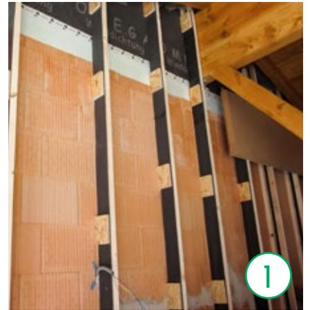
Je nach Dämmstärke werden für das Bilden der Hohlräume Holzlatten, Doppel-T-Träger oder Holzkonstruktionen an die Ziegelmauer gedübelt. Der Achsabstand richtet sich nach den Anforderungen des jeweilig verwendeten Putzträgermaterials.
