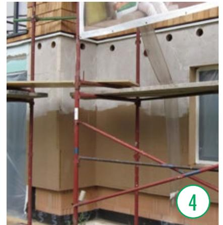
Kurz bevor die ISOCELL Zellulosedämmung eingebracht wird, werden in die Hohlräume Löcher für den Einblasschlauch gebohrt.
