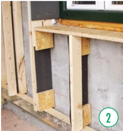
Fenster- und Türleibungen müssen rundum abgeschlossen werden. Hohlräume unter 10 cm werden per Hand mit Zellulose ausgestopft.
