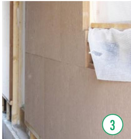
Auf die lotrecht ausgerichteten Abstandhalter wird das jeweilige Putzträgermaterial montiert. Bei hinterlüfteten Fassaden wird eine diffusionsoffene Holzwerkstoffplatte angebracht.
