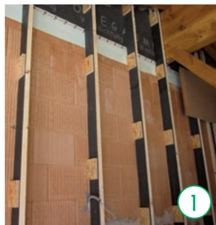
A seconda dello spessore coibente, per la creazione delle cavità vengono tassellati al muro assicelle di legno, travi a doppio T o costruzioni in legno. L'interesse si orienta alle esigenze del materiale di supporto portaintonaco di volta in volta utilizzato.
