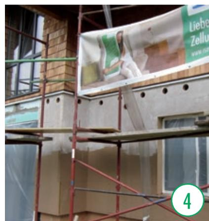
Poco prima di introdurre l'isolamento celluloso ISOCELL, vengono forate le cavità per il tubo d'insufflaggio.
