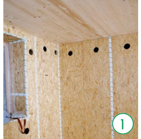
Holzriegelwände werden je nach Vorfertigungsgrad bereits im Werk oder auch vor Ort mit der Zellulose-dämmung befüllt.
