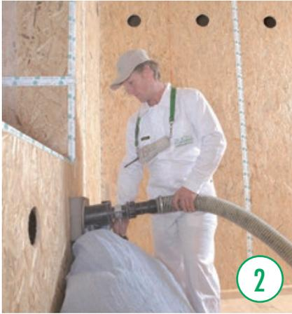
Mit Druck wird die Zellulose in die Hohlräume eingebracht - fugenlos und verschnittfrei. Der Fachmann arbeitet hier mit speziellen Einblasdüsen, die ihm ein rasches und sauberes Verfüllen ermöglichen.
