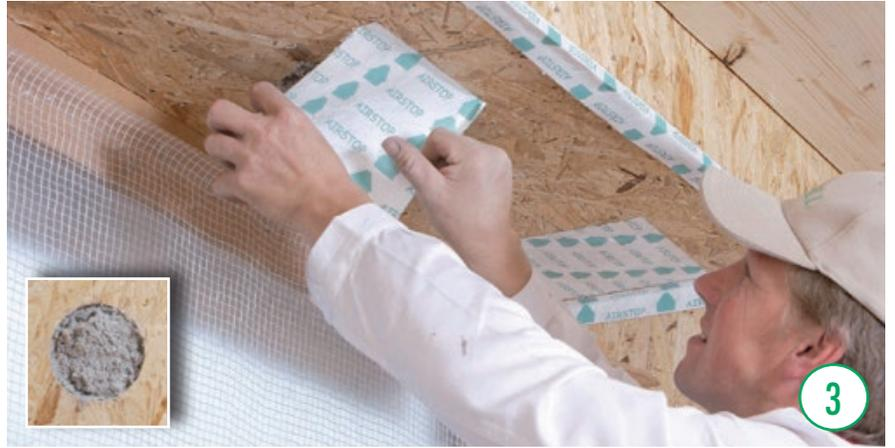
Die Zellulosefasern verfilzen sich im Bauteil zu einer kompakten passgenauen Dämmmatte. Sind die Hohlräume vollständig gefüllt, werden die Einblaslöcher mit den AIRSTOP FLEX Dichtpflastern luftdicht verschlossen.
