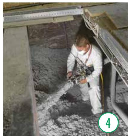
Bei der Aufsprühtechnik wird der Zellulosedämmung mittels einer speziellen Düse Wasser beigemischt. Mit diesem Gemisch lassen sich gewölbte Flächen ohne Fugen und Verschnitt in einer definierten Stärke dämmen.
