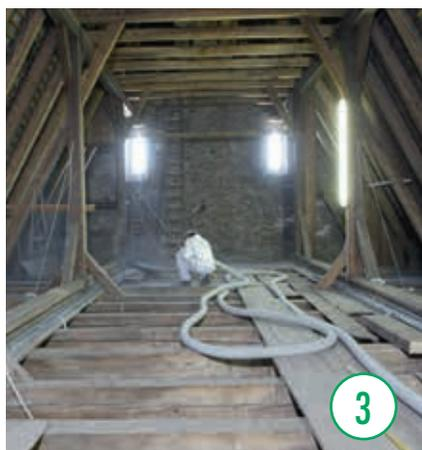
Im Dachraum steuert der Einblasfachmann den Materialfluss mittels Funk.
