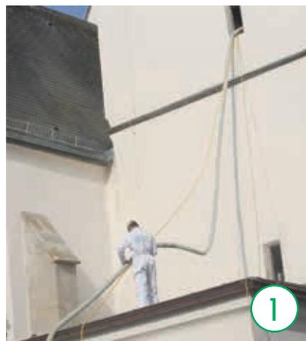
Kein Materialschleppen - es wird nur ein Förder-schlauch ins Gebäude geleitet. Bis zu 60 m weit fördern die leistungsstarken Einblasma-schinen von ISOCELL die Zellulosedämmung, selbst Kirchtürme stellen keine Herausforderung dar.
