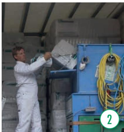
Dämmmaterial und Maschine bringt der Fachmann am LKW mit - kein Lagerproblem auf der Baustelle. Ein Mitarbeiter befüllt die Einblasmaschine im LKW kontinuierlich mit Zellulose.
