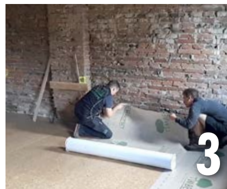
Liner am Beginn der Rolle lösen und TIMBER PROTECT SK fixieren.
