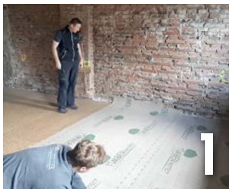
TIMBER PROTECT SK ausrollen und justieren.
