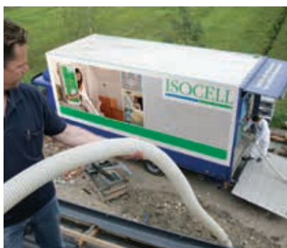
Der Schlauch wird an den Einsatzort gebracht.
