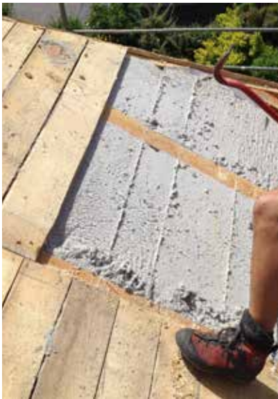
Nach 17 Jahre geöffneter Dachstuhl; Die ISOCELL Zellulose wirkt wie frisch eingblasen.
