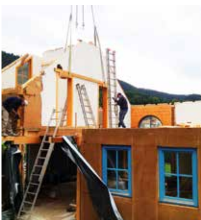
Nach 21 Jahren wird das Fertigteilhaus abgebaut. Beim Abtragen zeigte sich deutlich:
