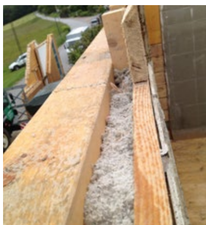
Que la cellulose dans les murs extérieurs et intérieurs est Intacte .
