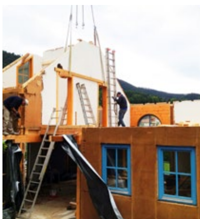
Démontage d'une maison préfabriquée après 21 ans on constate clairement:
