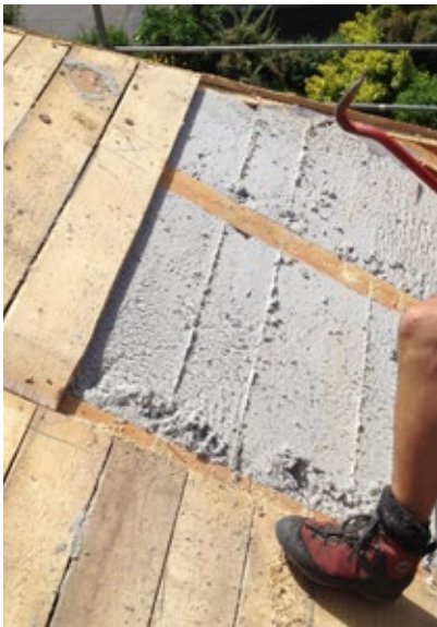
Na 17 jaar werd het dak geopend : De ISOCELL cellulose werkt zoals net ingeblazen
