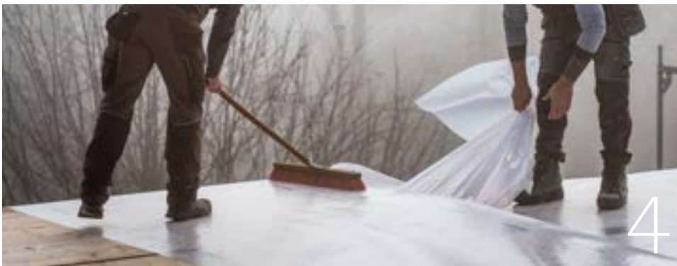
Restlichen Liner abziehen . Gleichzeitig mit einem weichen Kehrbesen (o.ä. Hilfsmittel) die Bahn eben drücken.
