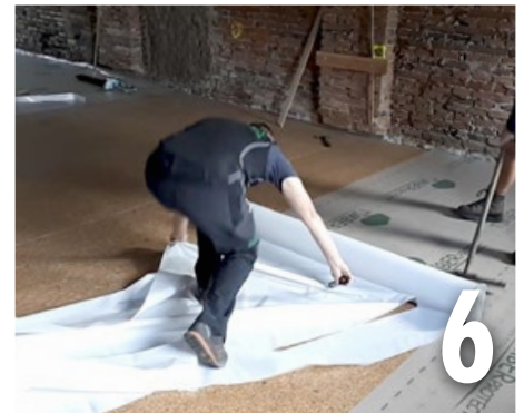
Sobald sich der Liner nicht mehr faltenfrei handhaben lässt, abschneiden und mit dem kurzen Ende den Liner wieder abziehen.
