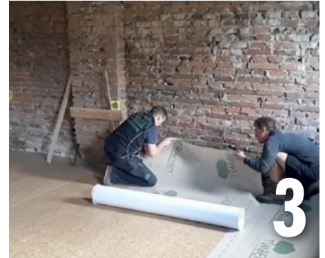
Liner am Beginn der Rolle lösen und TIMBER PROTECT SK fixieren.
