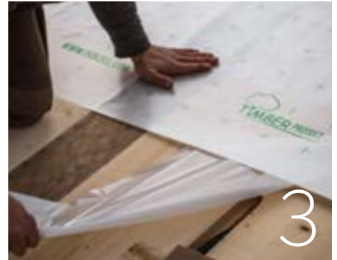
Schmaler Liner ablösen und TIMBER PROTECT SK mit Untergrund fixieren.
