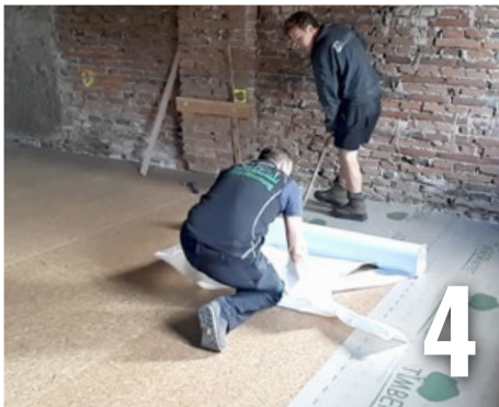
Liner abziehen. WICHTIG: die Rolle muss am Boden liegend ausgerollt werden, während der Liner abgezogen wird.
