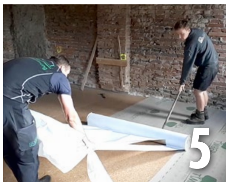
La membrane doit être parallèlement pressée de façon lisse au moyen d'une raclette. Toujours vers l'extrémité de la membrane pour empêcher les bulles d'air et les plis.
