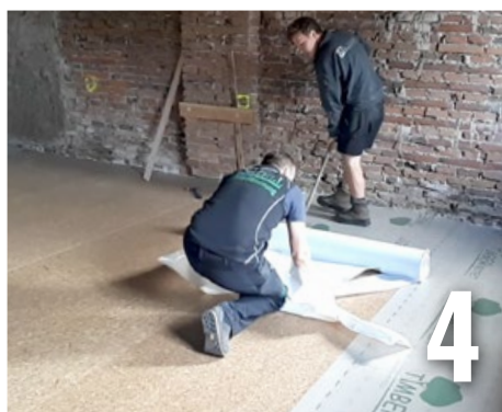
Retirer le liner. ATTENTION : le rouleau doit être déroulé à plat au sol pendant que le liner est retiré.
