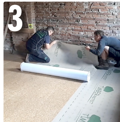
3 Liner am Beginn der Rolle lösen und TIMBER PROTECT fixieren
