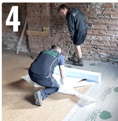
4 Liner abziehen. WICHTIG: die Rolle muss am Boden liegend ausgerollt werden, während der Liner abgezogen wird.
