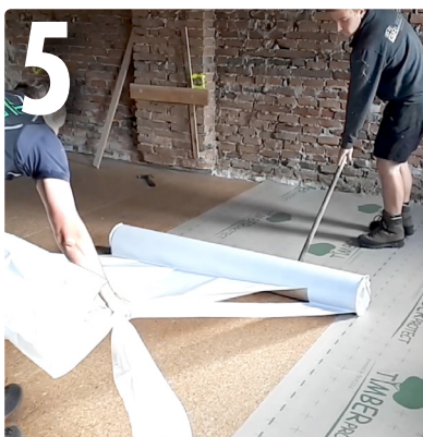
5 Gleichzeitig muss mit einer Abziehlippe die Bahn glatt gedrückt werden. Immer Richtung Ende der Bahn damit man Luftblasen und Falten verhindert.
