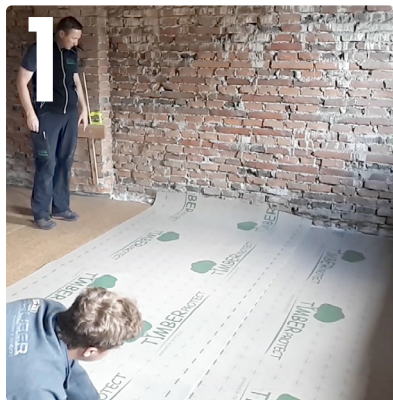
1 TIMBER PROTECT ausrollen und justieren
