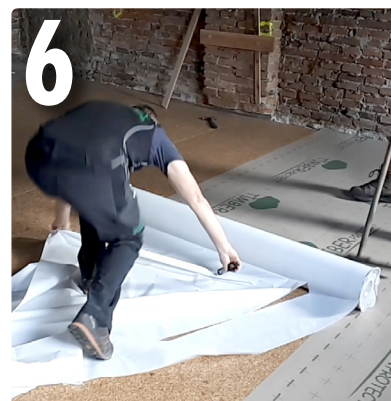
6 Sobald sich der Liner nicht mehr faltenfrei handhaben lässt, abschneiden und mit dem kurzen Ende den Liner wieder abziehen.
