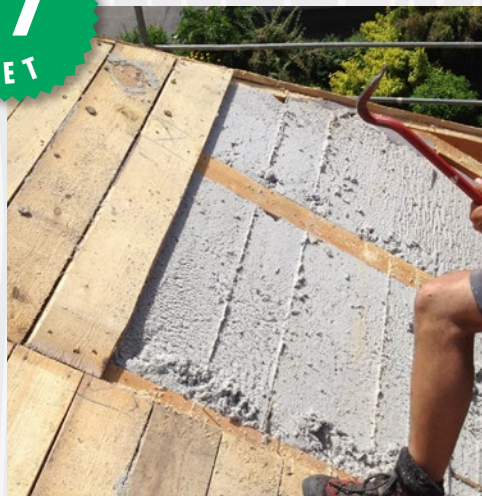
Sřecha rozebraná po 17 letech; (dům v tyrolsku) Celulóza ISOCELL působí jako čerstvě instalovaná.
