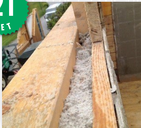
Po 21 letech byl demontován prefabrikovaný dům (dolní rakousko / Wr. Neustadt).
