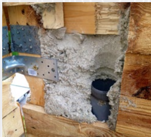
Die in den Außen- und Zwischenwänden zur Dämmung eingebrachte Zellulose wies keinerlei Setzung oder Verformung auf.
