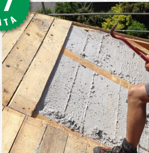
Konstrukcja dachu otwarta po 17 latach (dom w tyrolu) Celuloza ISOCELL funkcjonuje tak, jakby była świeżo
