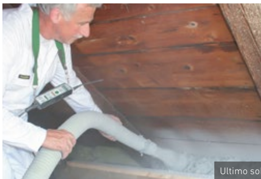
Insufflaggio soffitto
