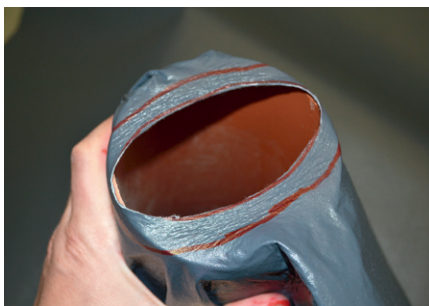
Formteil über das Rohr stülpen.
