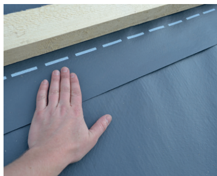
Unmittelbar nach dem Klebstoffauftrag überlappende Dachbahn gut andrücken.
