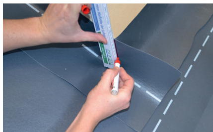
Kaminecke auf die Dachbahn projizieren.
