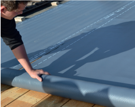
Verlegung und Fixierung auf festem Untergrund.
