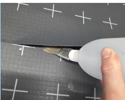
Überlappungsverklebung mittels OMEGA QSM Quellschweissmittel.
