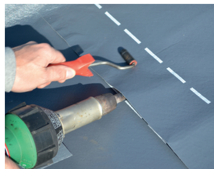
Überlappungsverklebung mittels Heissluftpistole.
